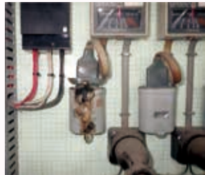
破裂・溶融した低圧進相コンデンサ
